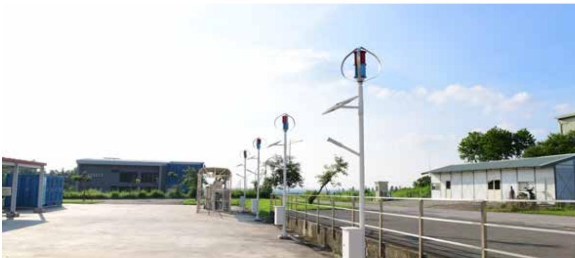
永續研發中心外側風力及太陽能發電路燈裝置
